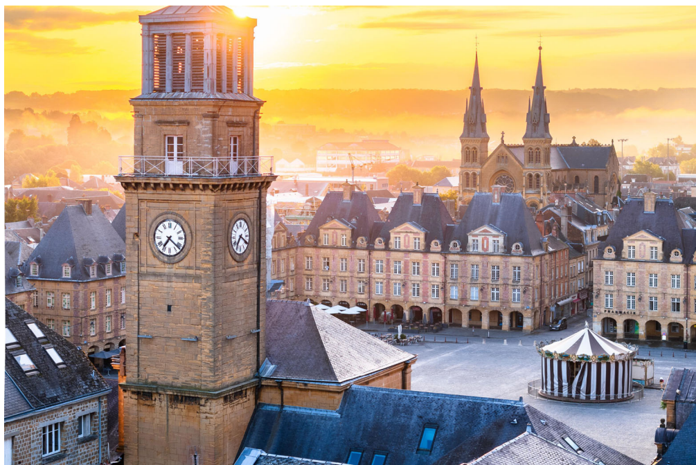
Vue aérienne du beffroi de la mairie, Charleville-Mézières
